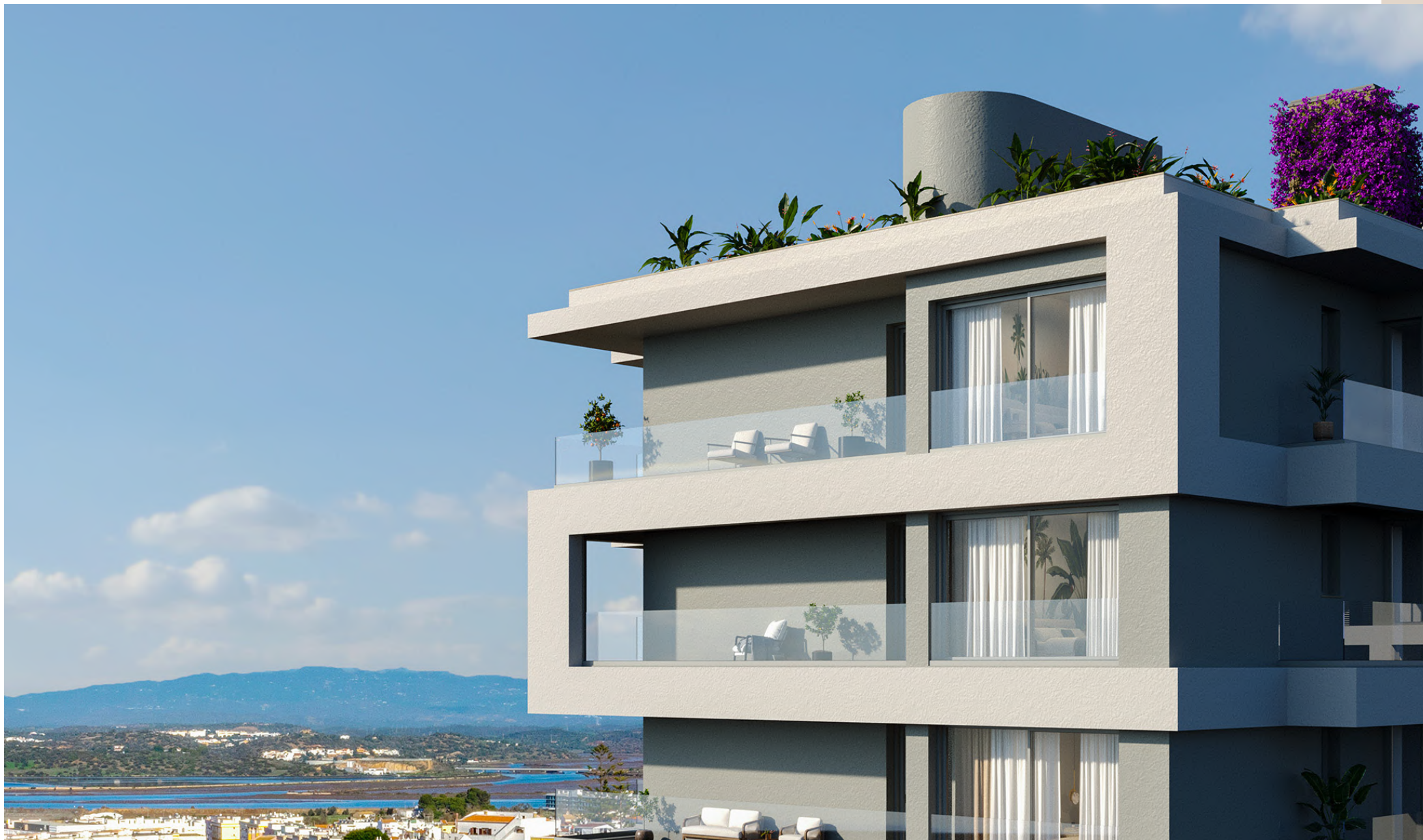
Vue sur le Rio Arade et la mer depuis les terrasses en étages et penthouses, exposition Ouest.
